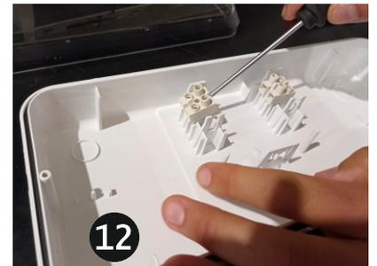
Retirer les bornes de connexion à l'aide d'un tournevis, comme indiqué sur les photos.
